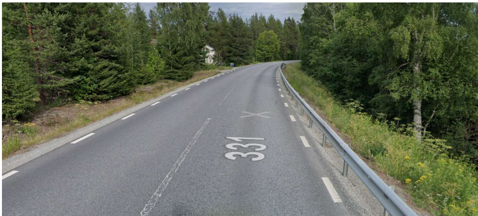
Figur 5. Bild från olycka Y331 Ärtrik anmäld till arbetsmiljöverket 2021-11.
