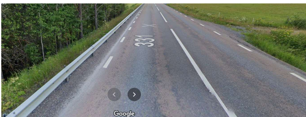
Figur 11. Bilden visar ett av många exempel längs utredningsförslagets vägsträcka där avstånd till räcke långt understiger de 0,5 m som Trafikverket krävställer för 80/100.
