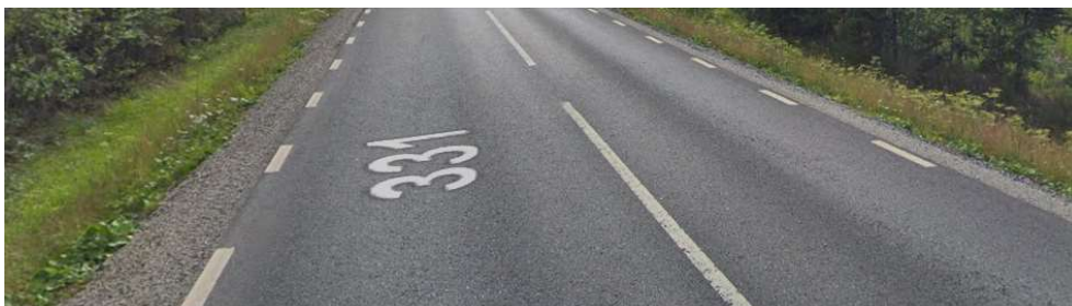
Figur 9. Bilden visar vägparti Näs men liknande längs hela utredningsförslagets beskrivna vägsträcka. Avsaknad av vägren och streck målade längs grus kant.
