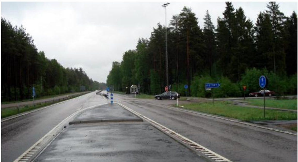
Bild 24: Passage av mötesseparerad väg – bred refug.
