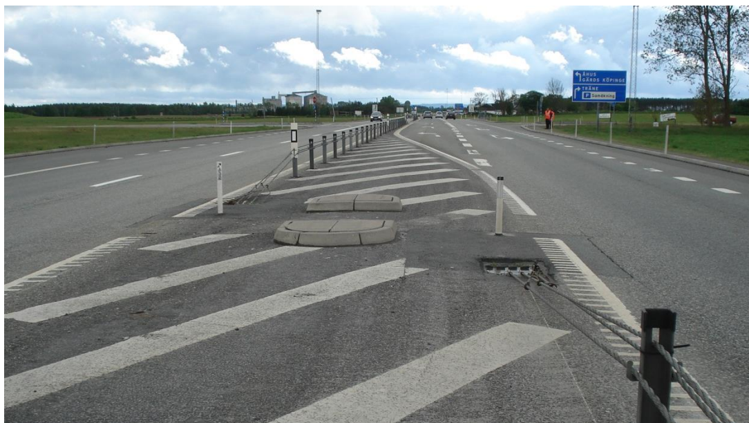
Figur 22: Exempel på korsandelösning utmed en mötteseparerad landväg. Passagen har försetts med mittrefug och pollare. Bildkälla: Ramböll, 2011.
