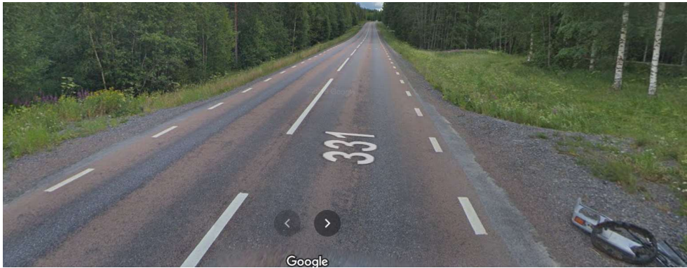
Figur 12. Bilden visar de släntar och icke befintliga vägrenar som omöjliggör framkomlighet för GCM, här i Hammar.
