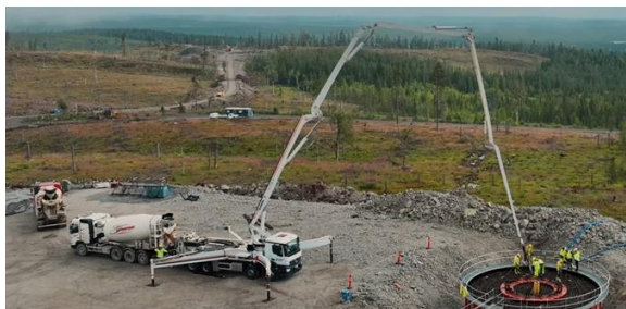
Det är för närvarande full aktivitet på samtliga projektområden. Här ovan Storhöjden, där fundamentsgjutningarna nu är klara.
